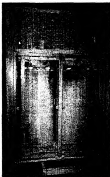
28 - rasm. Kuchlanishi 10-6 kVAi quvvati 1000 kVA li TS 1000/10-6 quruq transformator.
