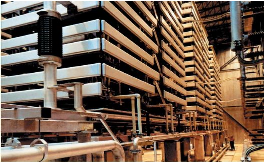
39-rasm. Shatagay (Kanada) O‘TK ning ventilli zali. Siemens firmasining jihozlari
