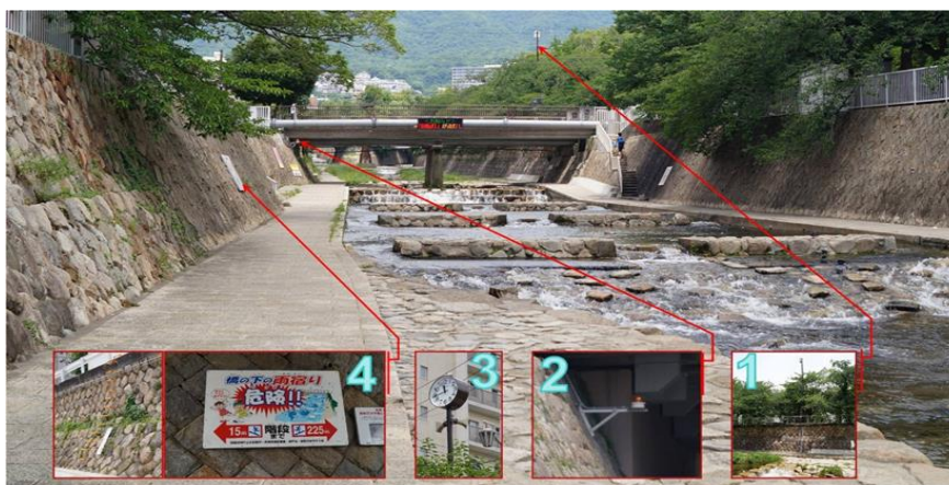
7.12-rasm.Tablolar va ovozlovchi xabar beruvchi gidrologik qurulma
