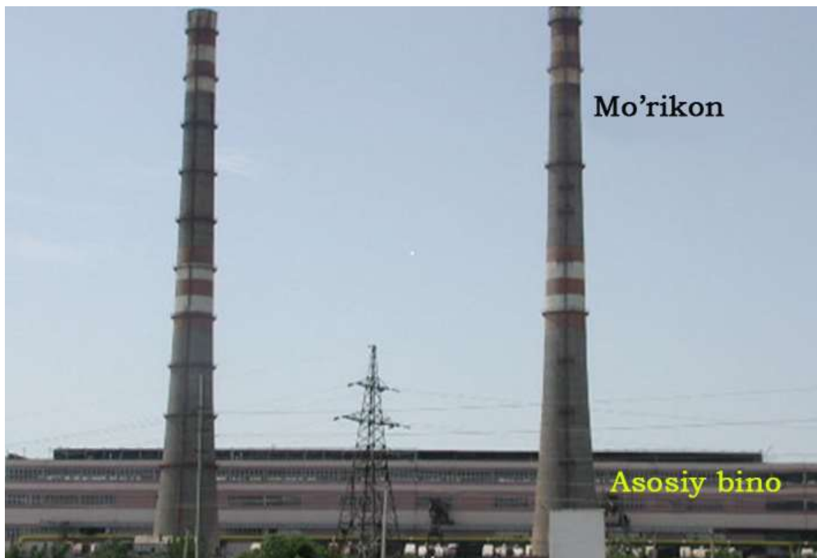
5.4-rasm. Elektr stansiyada mo'rining joylashuvi
