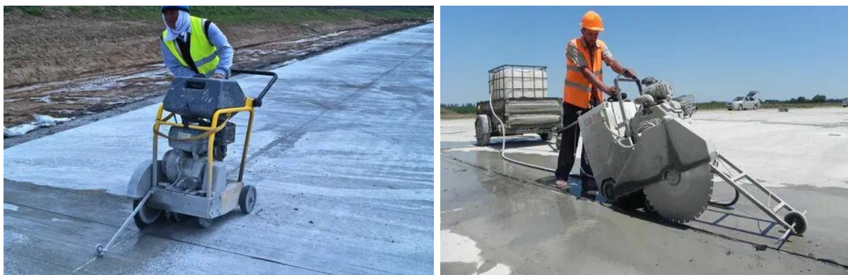
2.21-rasm. Yangi yotqizilgan betonda deformatsiya choklarini kesish
