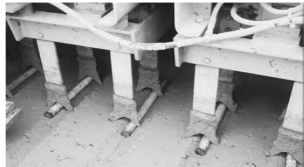
2.29-rasm. Betonlash paytida shtirlarni botirish
