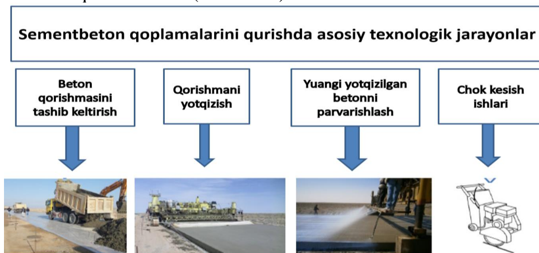
2.14-rasm. Sementbeton qoplamalarini qurishning texnologik jarayonlari
