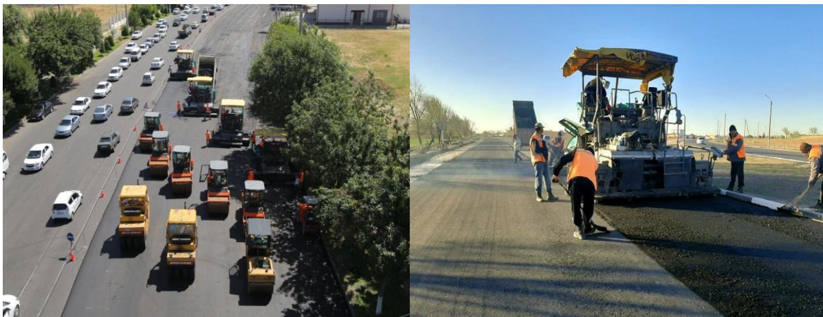
1.31-rasm. Issiq asfaltbeton qorishmasini yo'lga yotqizish texnologik jarayoni
