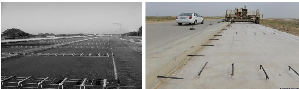
2.16-rasm. Armatura karkaslarni betonlashdan oldin asosga o'rnatish
