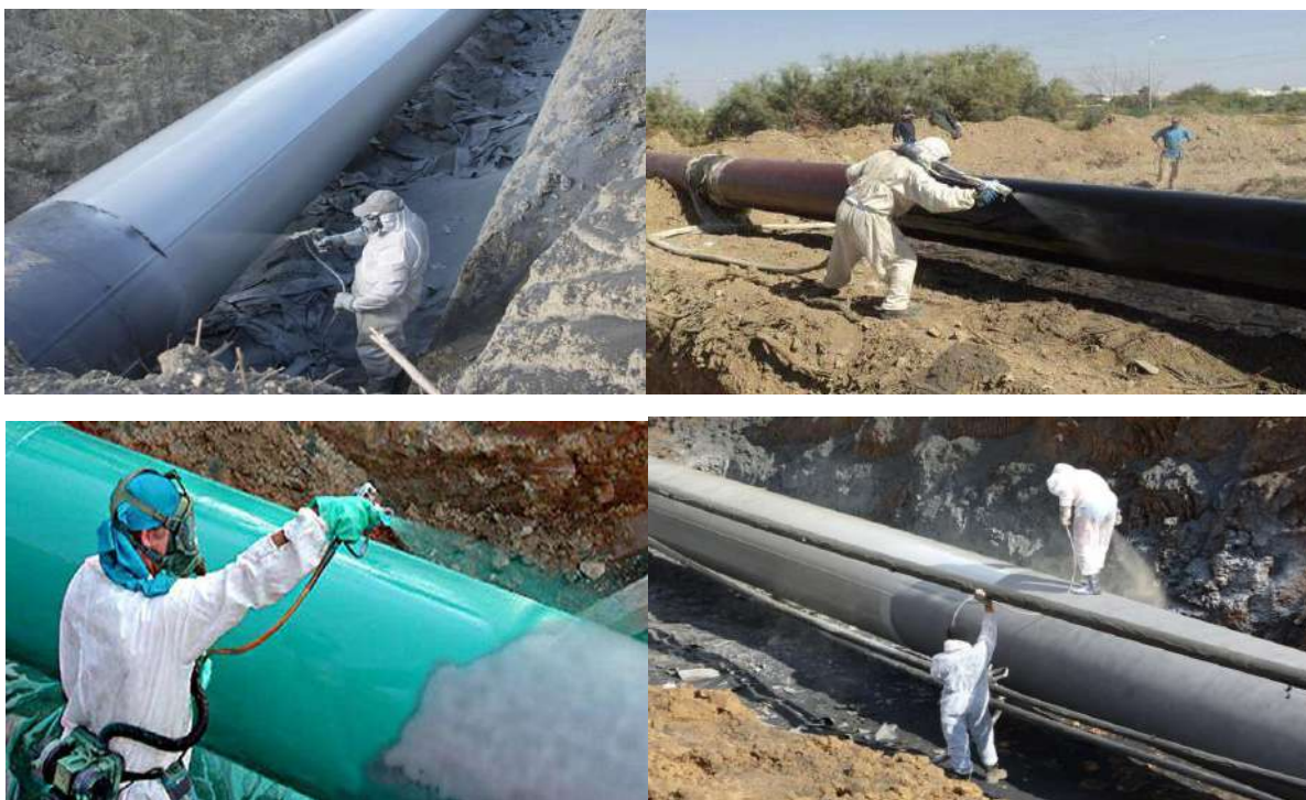
VI.3-rasm. Quvurlarni korroziyadan himoya qilishning lak bo‘yoqli qoplamalari.
