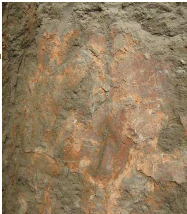
Рис. 23. Сохранившаяся штукатурка темно-красного (обожженного) цвета
