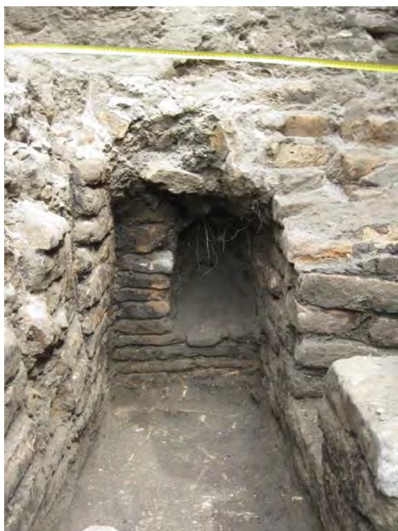
Рис. 11. Соединение внутрстенного дымохода с жаровым каналом
