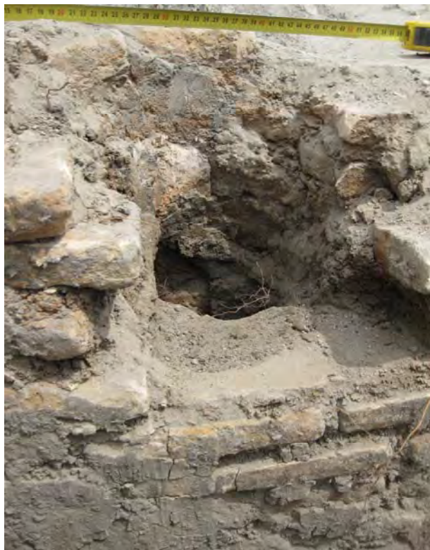
Рис. 10. Внутрстенный дымоход внешней стены. помещения 5 в.
