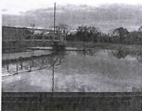
45-rasm. Radial birlamchi tindirgichlar.
