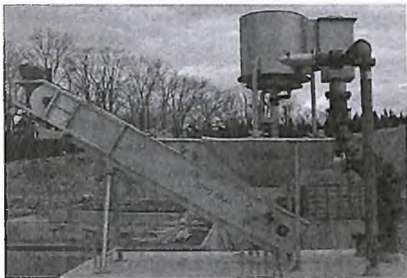
42-rasm. Yuqori samarali qum yuvgich «Eutek SlurryCup™» / shlamni qumsizlantirish qo'zg'almas suvsizlantirish eskalatorida o'rnatiladi Eutek Grit Snail.
