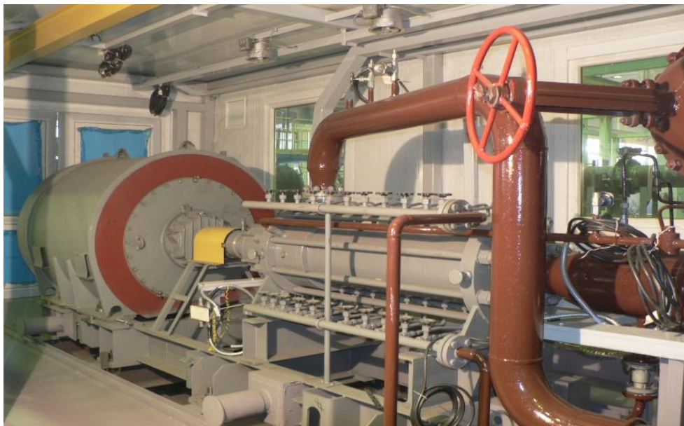
2.2- rasm. Neft va neft maxsulotlarini bir joyga to'plash va tayyorlash sistemasi bajaruvchi nasos vositasi yordamida bir joydan boshqa joyga o'tkazuvchi blokli (chig'iriqli) nasosli stansiya ko'rinishi.
