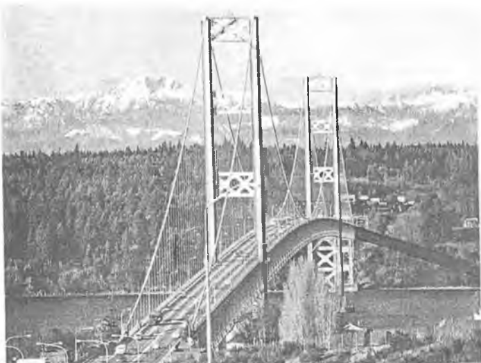
Asfaltbeton bilan qoplangan temir konstruksiyali osma ko'prik
