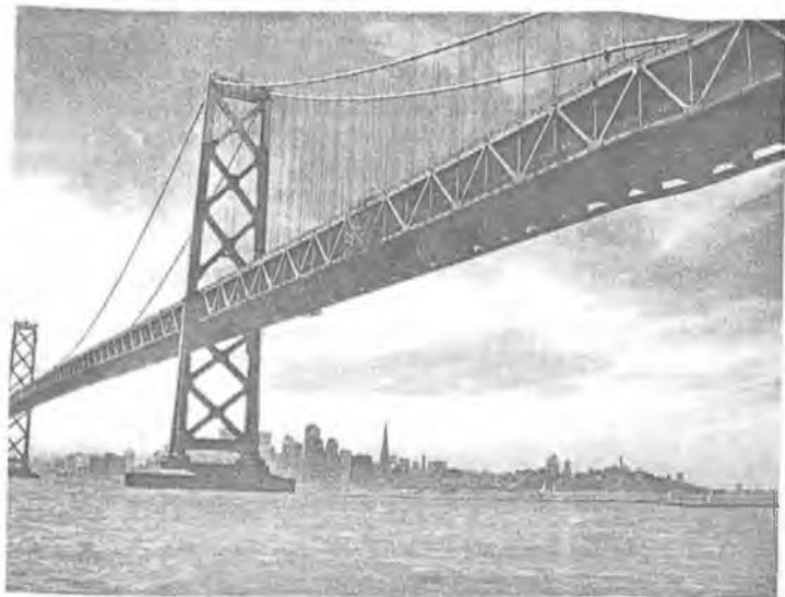
Temir konstruksiyali ko'prik.
