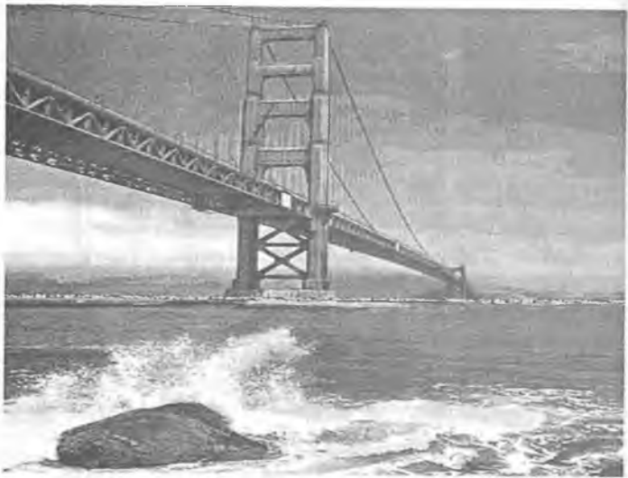
Temir arqon (kanat)ga osilgan temir konstruksiyali ko'prik.
