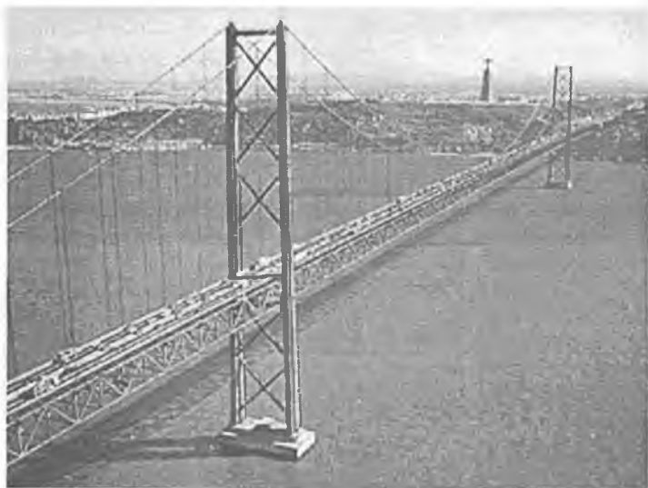
Temir kanatga osilgan temir konstruksiyali ko'prik.
