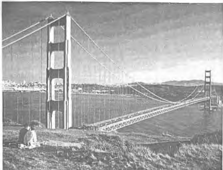
Temir-beton poydevorga oʻrnatilgan temir kanatli osma koʻprikl.
