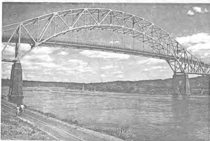
Temir-beton poydevorga o'rnatilgan konstruksiyali osma arka ko'prik.
