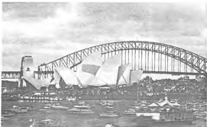
Arkali temir konstruksiyadan ishlangan ko'prik.
