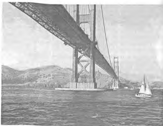
Asfalt-beton bilan qoplangan temir konstruksiyali osma ko'prik.
