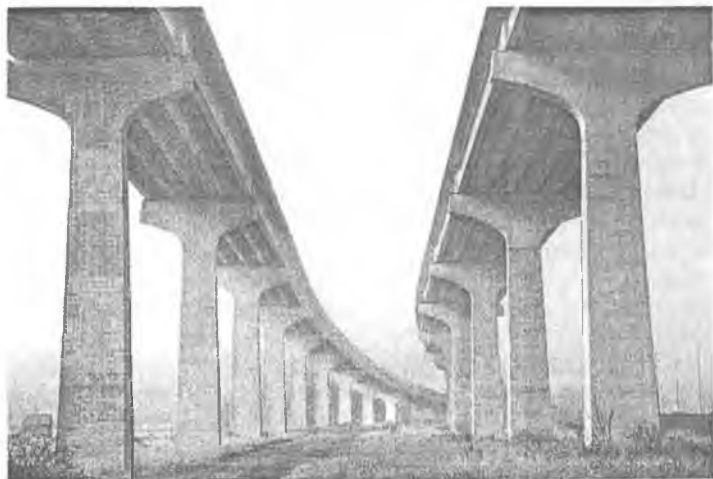
Temirbeton konstruksiyali avtomobil ko'prigi.
