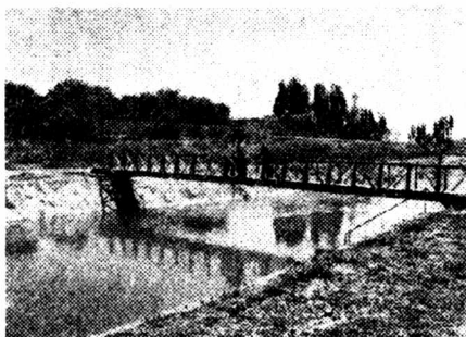
1.2 - расм. Ўзгармас ўзан типидаги гидропост.
