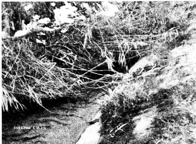
5.16 - расм. Бетон каналлар четини ўт босиши
