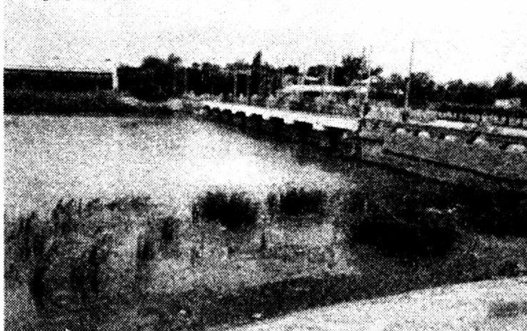
5.12 - расм. Жанубий Мирзачўл каналининг ПК 145 даги гидроузелни юкори бьефи ўзанида ўсган сув ўтлари
