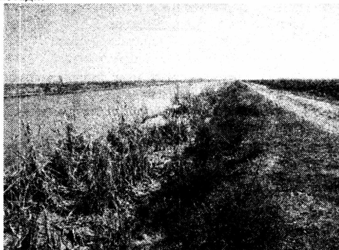
5.9 - расм. Канал қирғоғини ўт босиш ҳолати
