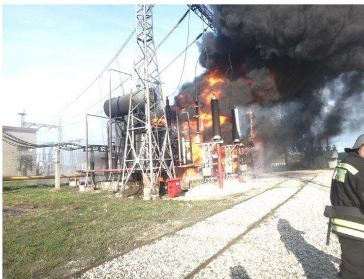
Рисунок 2.5. Производство работ по предотвращению аварий и ликвидации их последствий.
