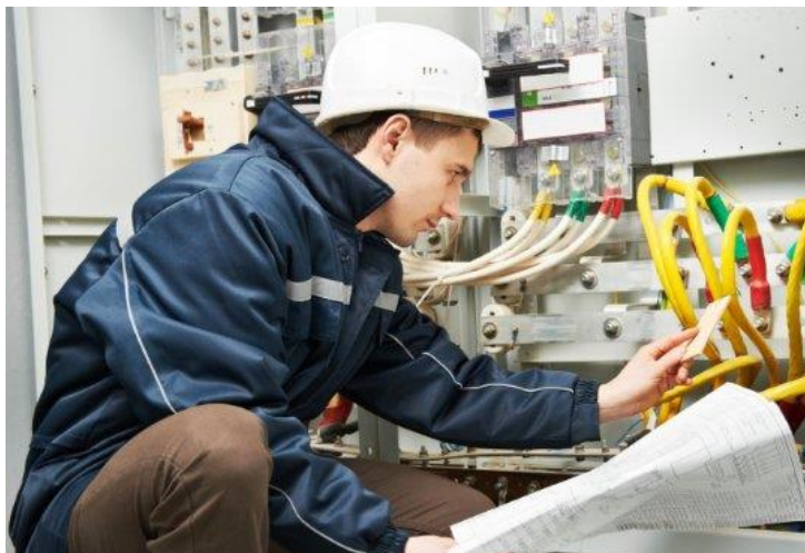
Рисунок 2.4. Включение электроустановки после полного окончания работ
