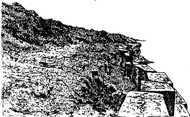
96- расм. Алоҳида- алоҳида қуйма бетон блокларидан иборат тўлқинқайтаргич деворлар.
