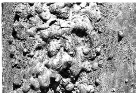
Рис. 9.4. Коррозия — это разрушение металла при его физико-химическом или химическом взаимодействии с окружающей средой
