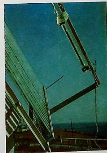
Рис. 3. Комбинированные фототермические преобразователи с солнечными элементами в вакуумированных оболочках крупным планом
