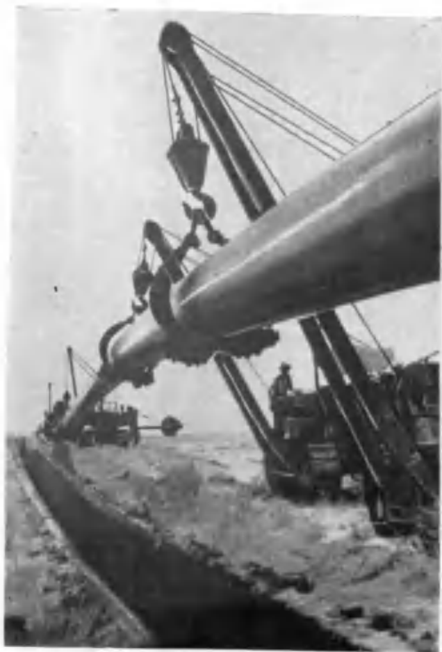
Газопровод утказиш Прокладка газопровода.
