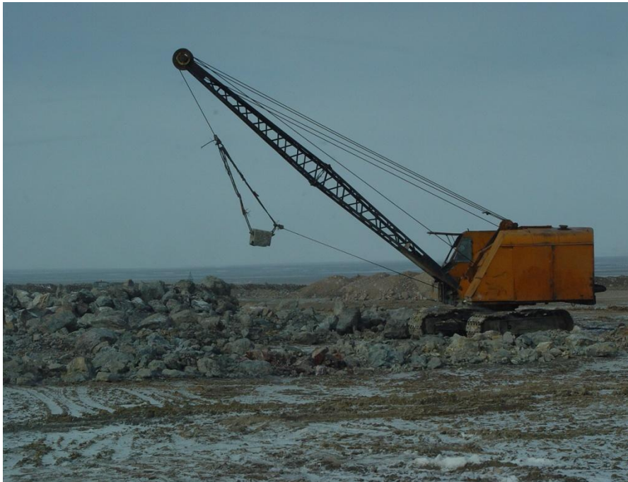
9.2 Rasm. Draglaynning umumiy ko‘rinishi.
