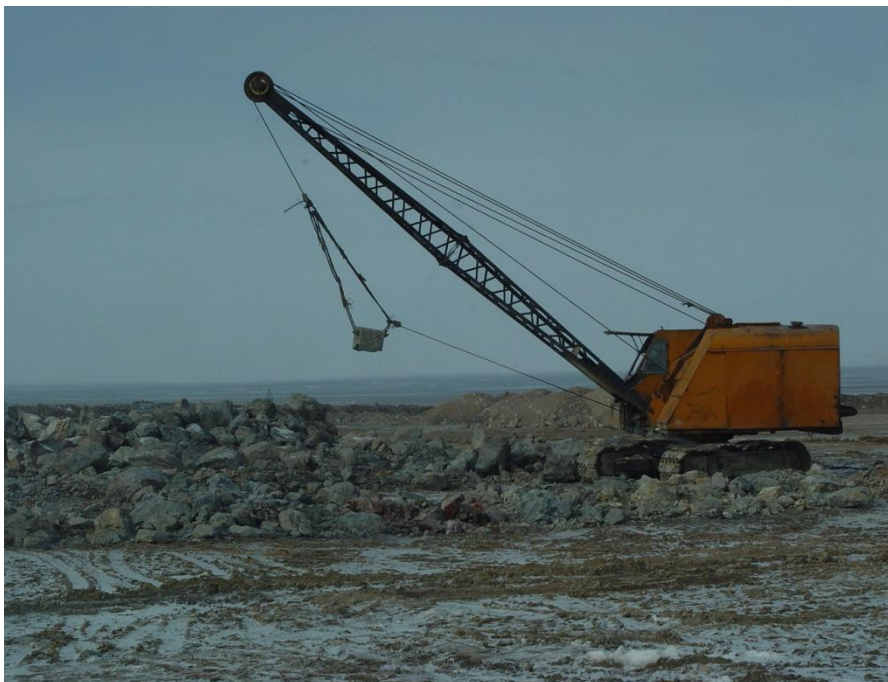
9.2 Rasm. Draglaynning umumiy ko‘rinishi.
