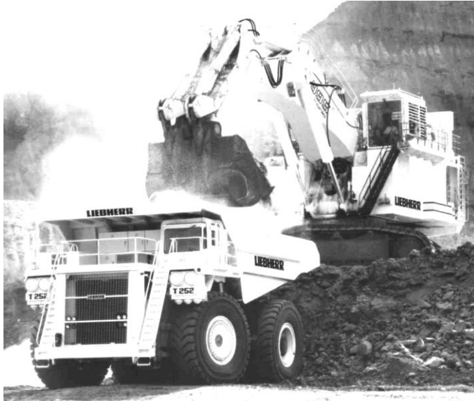
Рис. 5.9. Погрузка гидравлическим экскаватором «Liebherr» в автосамосвалы
