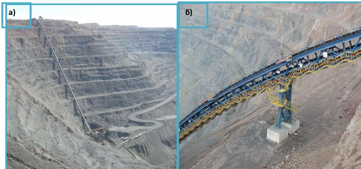
*Рис. 2. Общий вид на комплекс КНК-270 (а), расположение поддерживающей опоры и конвейерной линейной секции КНК на*
