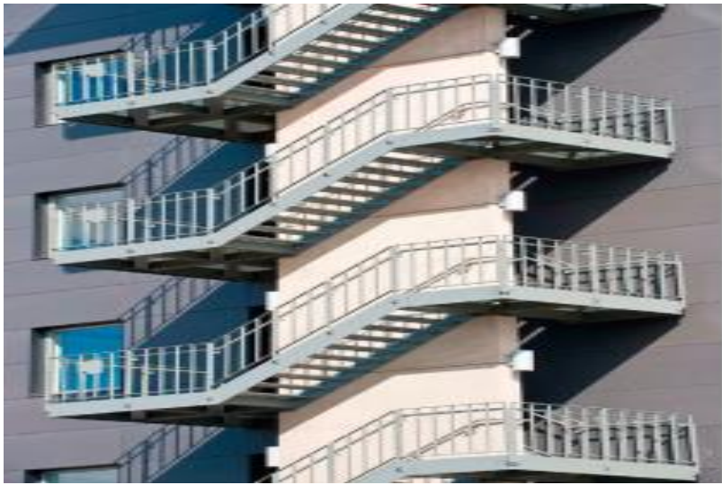
5.3 – rasm. Ko'p qavatli binoning tashqi yong'in qochish yo'lagi
