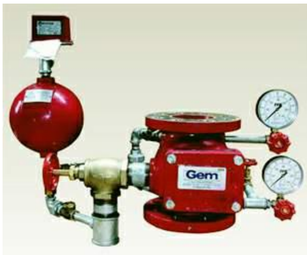
5.23-rasm. Avtomatlashgan yongʻin oʻchirish qurilmasining boshqaruv signal berish qismi
