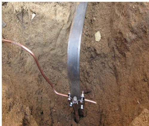
3.9 – rasm. Vertikal elektrodni transheyaga oʻrnatish qurilmasi
