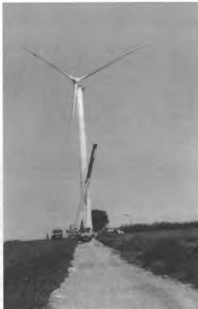
Рис. 12. Его мощность 670 кВт. Он будет производить электроэнергию на 130 тыс. долларов в год
