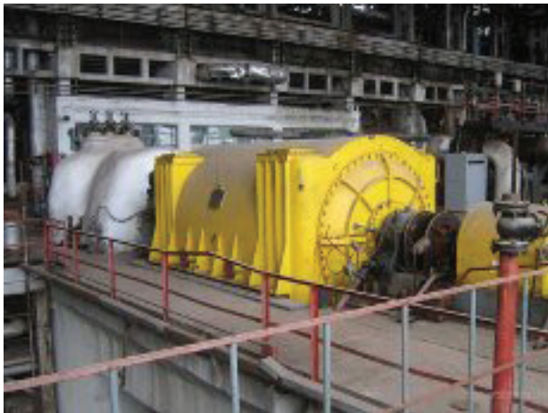
Рис. 4.4. Противодавленческая турбина 25 МВт с турбогенератором ТВС–30 (справа)
