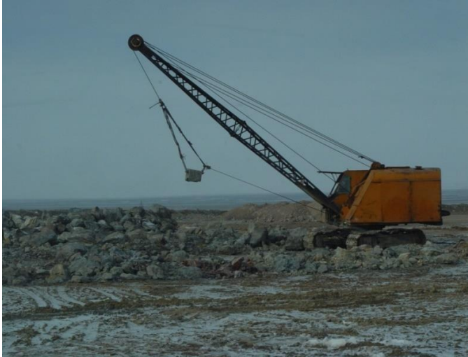
9.1 Rasm. Draglaynning umumiy ko'rinishi.
