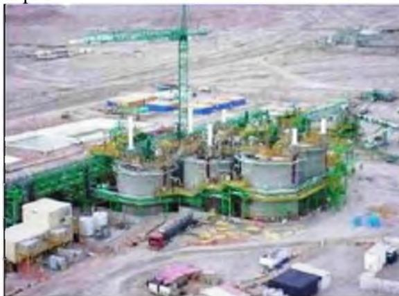
Рис.6.17. Каскад реакторов биовыщелачивания с использованием термофильных бактерий на заводе в Чукуикамате (Chuquicamata) в Чили.
