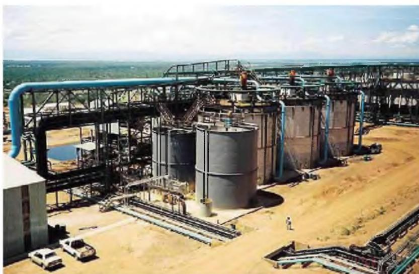
Рис. 6.15. Каскад из шести биореакторов на заводе Касисе Кобальт Компани.
