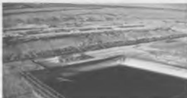
Рис. 71. Приемная емкость и общий вид кучи хвостов флотации.
