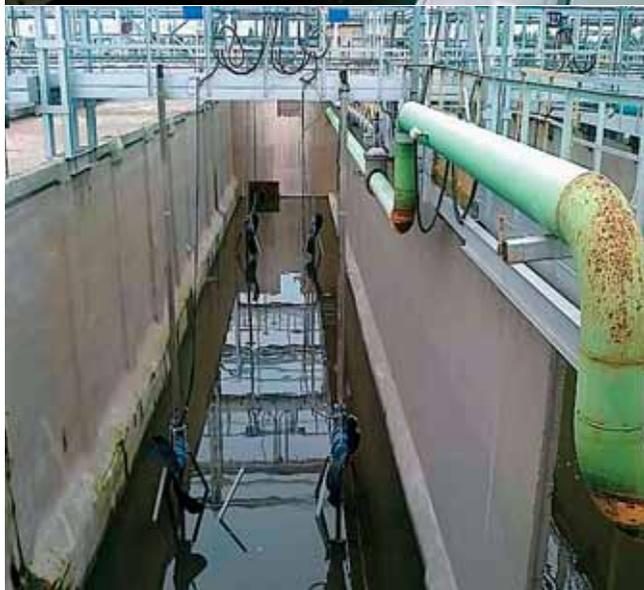
РИСУНОК 2. КАМЕРЫ ДЕФОСФАТАЦИИ
