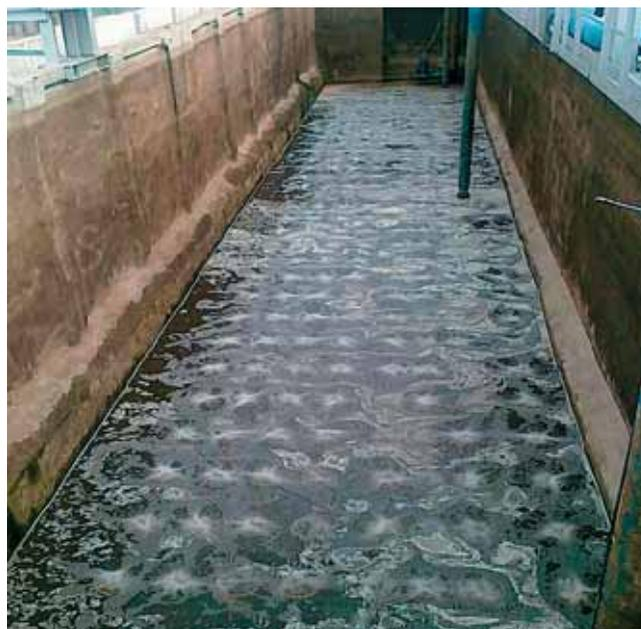
РИСУНОК 4. КАМЕРА НИТРИФИКАЦИИ
