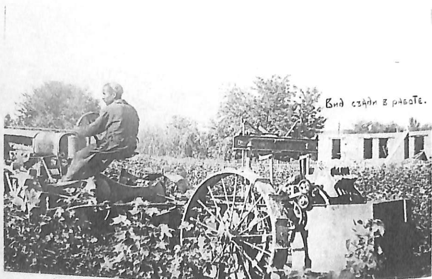
Шпинделли пахта териш машинаси (орқа томондан кўриниши)
