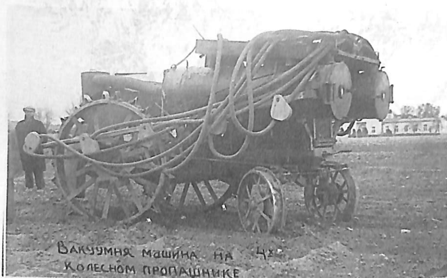
Вакуумли пахта териш машинаси (умумий кўриниши)
