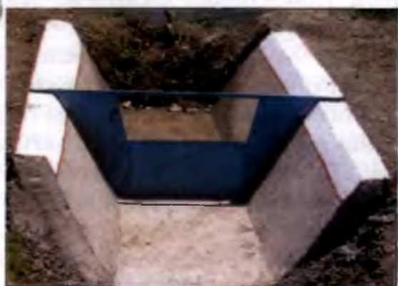
3.5-расм. Чиполетти сув ташлагичининг умумий кўриниши
