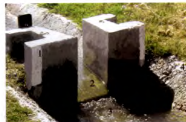
3.8-расм. САНИИРИ сув ўлчагич новининг пастки бьефдан кўриниши: 1 – новнинг пастки бьеф девори; 2 – новнинг асоси; 3 – каналнинг туби; 4 – каналнинг ён деворлари
