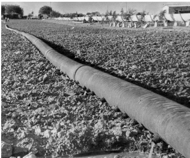
27- расм. Сарфи ростлаб туриладиган сув чикаргичли эгилувчан шланглар билан гўзани эгатлаб суғориш.
