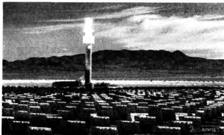
22-rasm. Dunyodagi eng kuchli quyosh elektr stansiyasi (Avstraliya).
