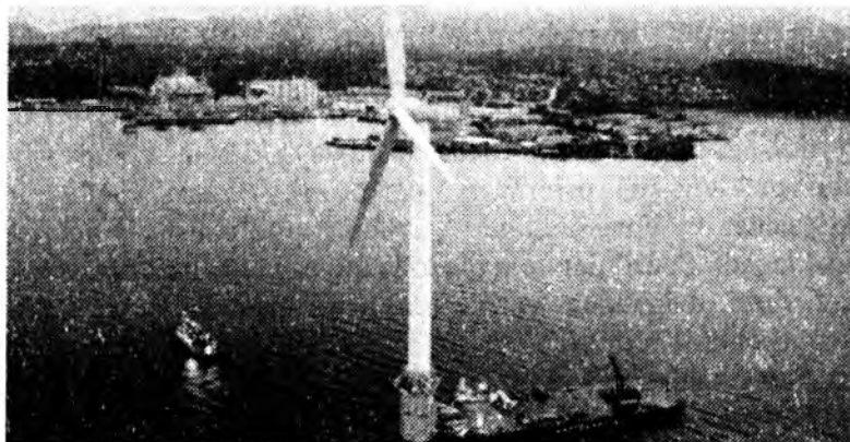
24-rasm. Suzuvchi shamol elektrostansiyasi (Shotlandiya).
