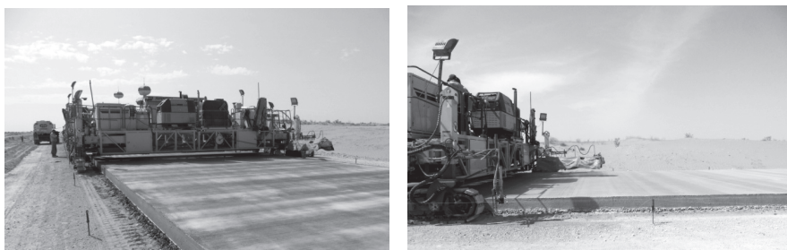
4.29-расм. Қопламаси юзаси гадир-будир қилиниб, кейин плёнка ҳосил қилувчи моддани пуркаш ишлари автоматик равишда бажарилиши.
