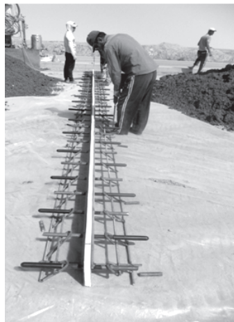
4.14-расм. Кенгайиш чоклари учун қистирма ва штирларни тайёрлаш ва ўрнатиш жараёни.
