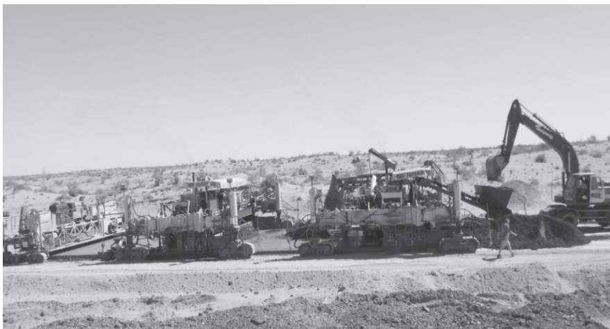
4.26-расм. Цементбетон қопламасининг бир вақтнинг ўзида икки қатлам қилиб ётқизилиши.
