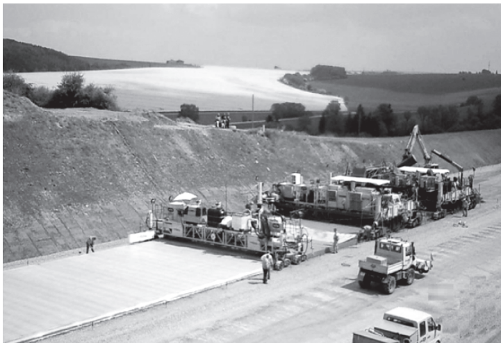
4.10-расм. «Wirtgen» фирмасининг SP-1500 моделидаги бетонётқизгичи.
