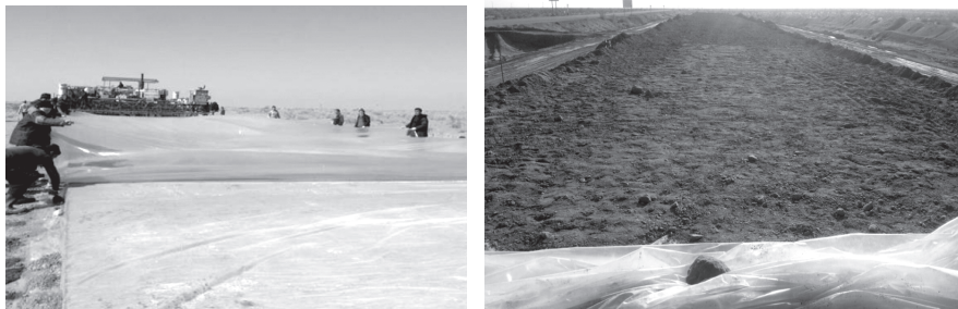
4.24-расм. Юқори ҳароратларда ётқизилган қоплама қарови учун бажариладиган ишлар кетма-кетлиги.
