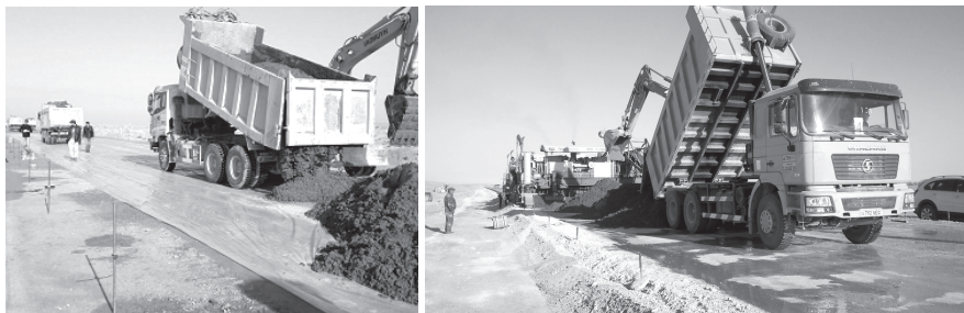
4.15-расм. Ташиб келтирилган бетон қоришмаси.
