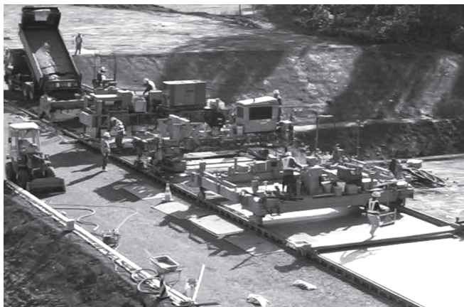
4.8-расм. Бетон қопламасини рельс қолиплар ёрдамида қуриш технологияси.
