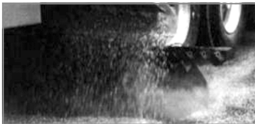
12.11-расм. Қоплама сиртига ишлов беришда материалларни синхрон усулда тақсимлаш.
