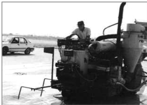
11.9-расм. Цементбетон қопламалар гадир-будирлигини тиклаш.
