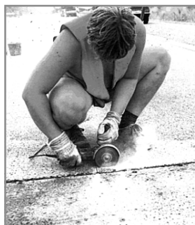
11.5-расм. Цементбетон чокларига қўлда ишлов бериши.
