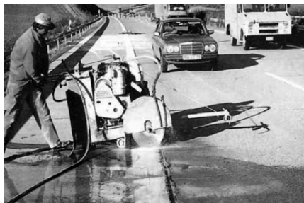
11.4-расм. Махсус машинада цементбетон чокларига ишлов бериши.
