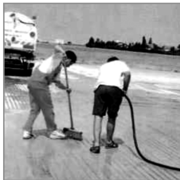
11.9-расм. Цементбетон қопламалар гадир-будирлигини тиклаш.
