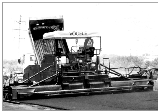
7.4-расм. Битта асфальт ётқизгич билан қоришмани ётқизиши.
