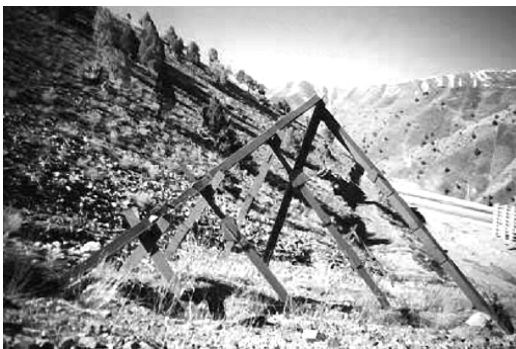
10.8-расм. А-373 «Тошкент-Ўш» автомобиль йўлининг 162 км га ўрнатилган кўчкига қарши иншоотлар.
