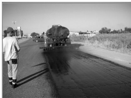
12.7-расм. Боғловчиларни қоплама юзасига сепишнинг умумий кўринишлари.
