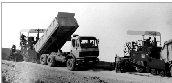
7.7-расм. Кетма-кет ишлаётган асфальт ётқизгичларнинг қоришмани ётқизиш жараёни.
