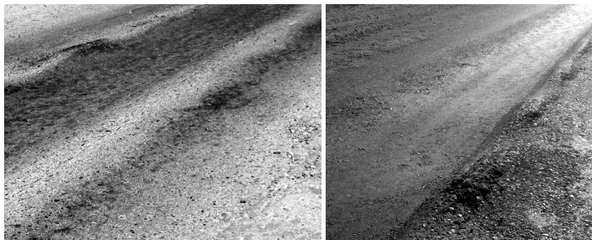
5.17-расм. Қопламада ботиқ изнинг кўриниши.
