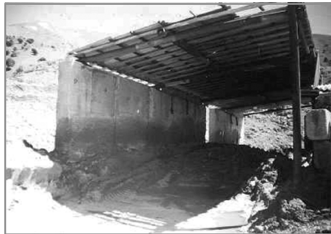
10.10-расм. Сирпанчиқликка қарши ишлатиладиган материалларни сақлаш жойи (А-373 «Тошкент-Ўш» автомобиль йўлининг 165 км).
