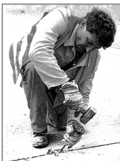
11.5-расм. Цементбетон чокларига қўлда ишлов бериши.
