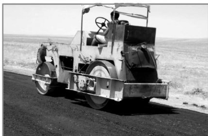
11.7-расм. Битумминерал ва нефтминерал қопламаларни ўрта таъмирлаш.
