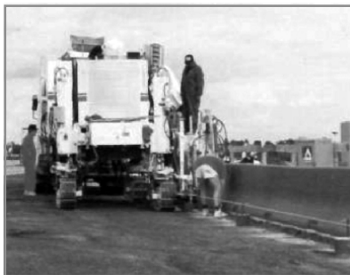
11.6-расм. Цементбетон қопламаларининг чокларини тўлдириш ва таъмирлаш.
