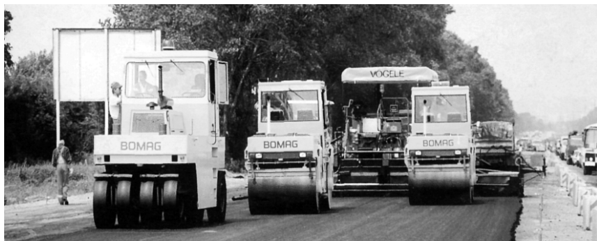
7.12-расм. Ётқизилган қоришмаларни ҳар хил катокларда зичлаш.
