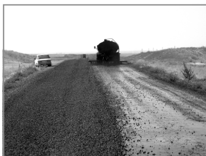
12.7-расм. Боғловчиларни қоплама юзасига сепишнинг умумий кўринишлари.
