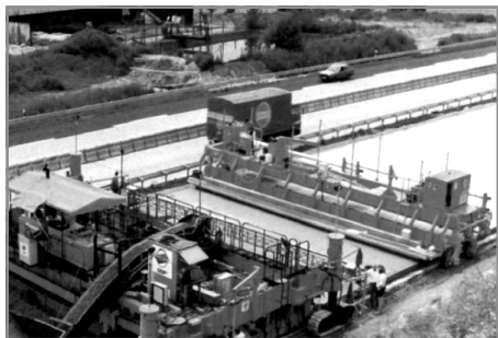
11.6-расм. Цементбетон қопламаларининг чокларини тўлдириш ва таъмирлаш.
