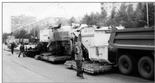
11.19-расм. Қопламаларни «Ремикс»да регенерация қилиш.
