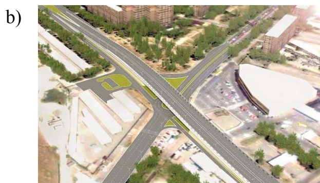
1.43-rasm. Ikki ko‘cha kesishgan joyda harakatlanish sxemasi: a – bir sathda; b – turli sathlarda
