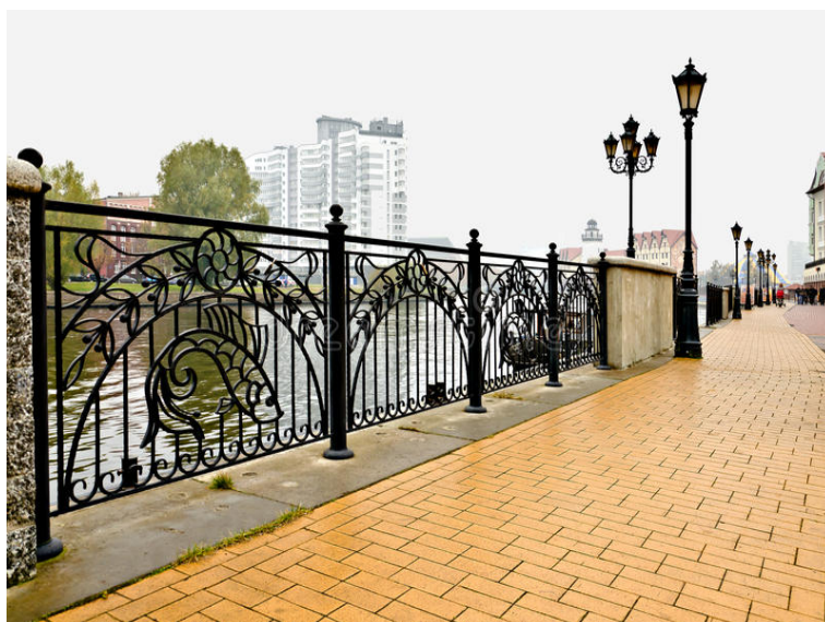
4.29-rasm. Yig‘ma perilaning po‘lat seksiyasi
