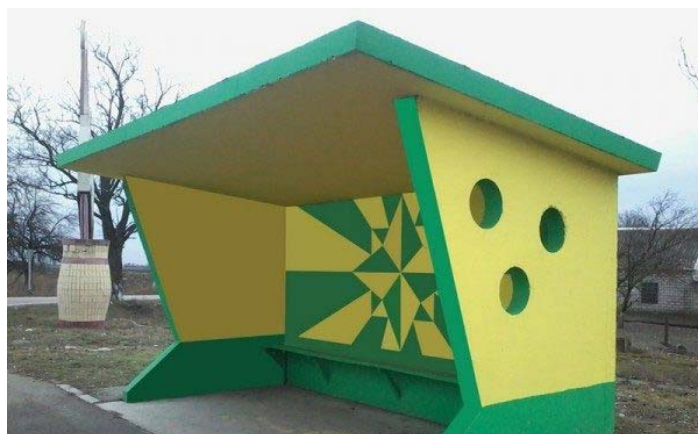
4.3-rasm. Yig‘ma temirbeton elementli pavilyonlar
