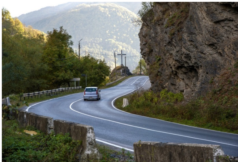
1.26-rasm. O‘simliklar bilan qoplangan tog‘ yonbag‘rini yo‘l poyi qurilishida ochilib qolib buzilgan ko‘rinishi
