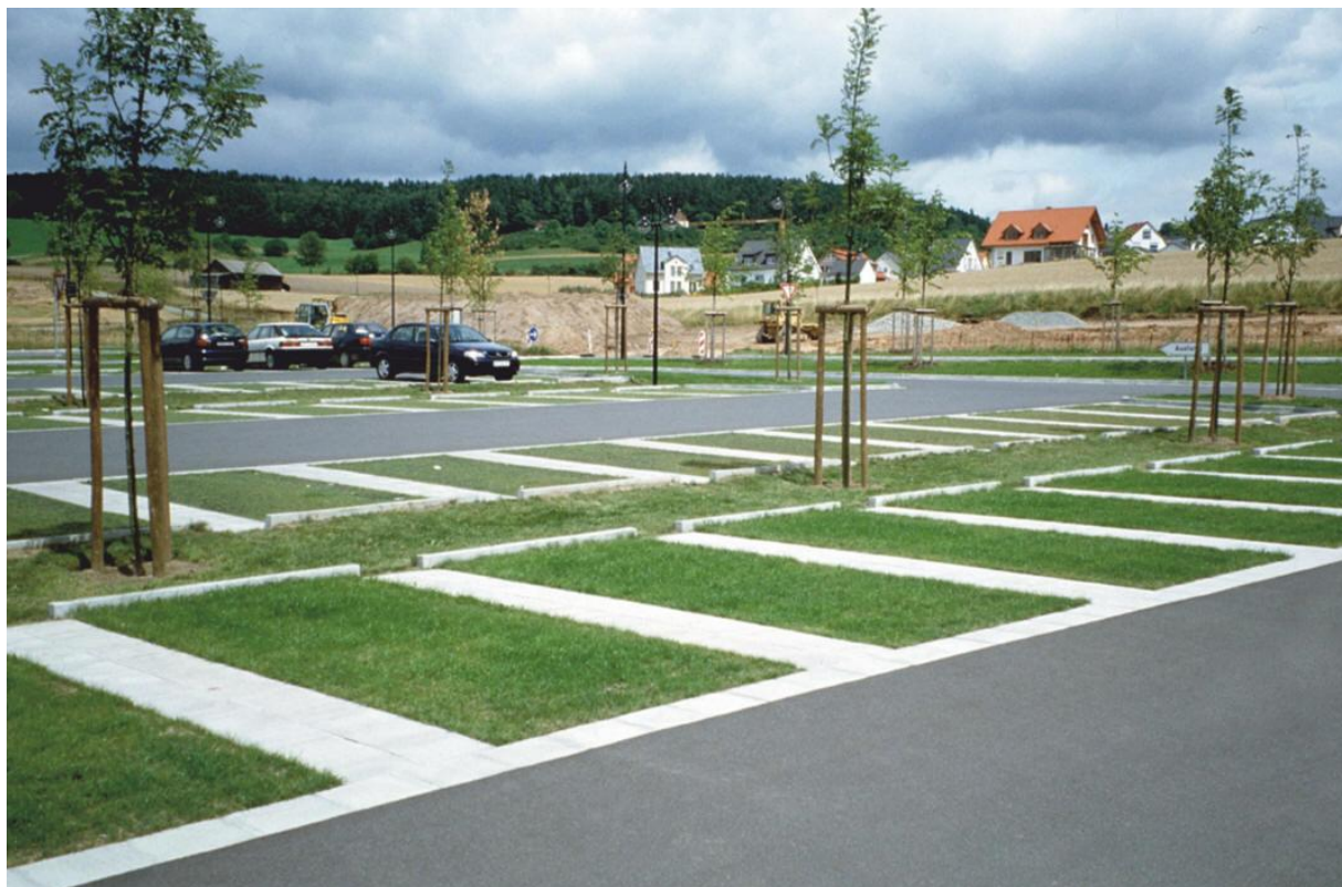
Avtomobillarni to'xtash joyida ko'kalamzorlashtirish uchun ekilgan daraxtlarga tirgovichlar qo'yish
