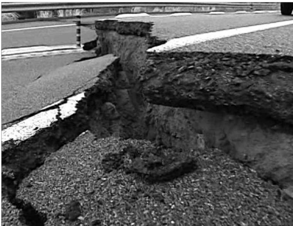
5.27-rasm. Oxirgi ulkan sunami bilan kuchli zilzila 2011 yil 11 martda yuz bergan edi va avtomobil yo'llariga katta zarar yetkazdi (6 milliy avtomagistral Xaro-No-Mati, Fukusima prefekturasi)
