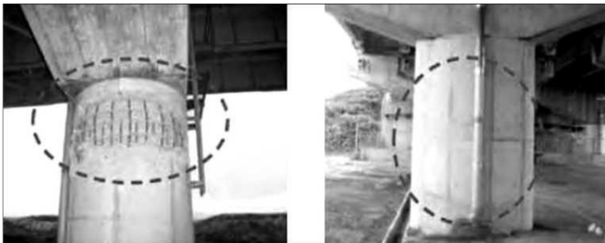
5.30-rasm. Chap tomonda seysmik himoyasiz ko'priklar tayanchi, o'ngda esa kuchaytirilgan temirbeton qoplamali tayanch
