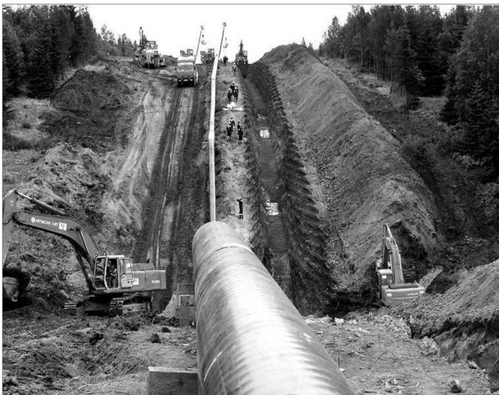
7.1-rasm. Chiziqli magistralning yerusti quvurining qurilishi
