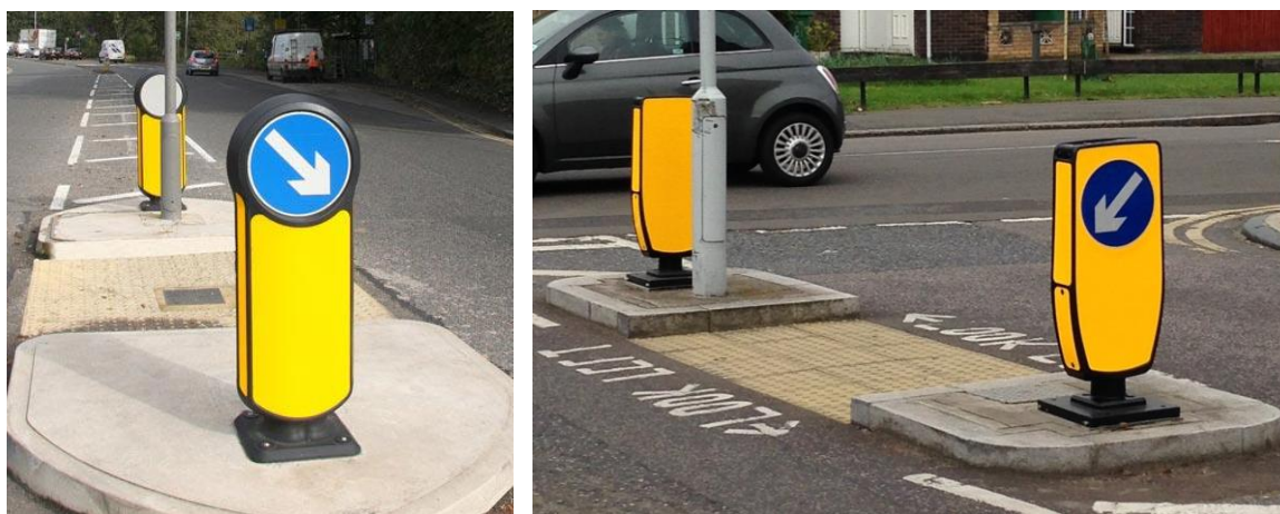
5.14-rasm. Yo'naltiruvchi ustunchalarni yo'lning ko'ndalang kesimida o'rnatish.
