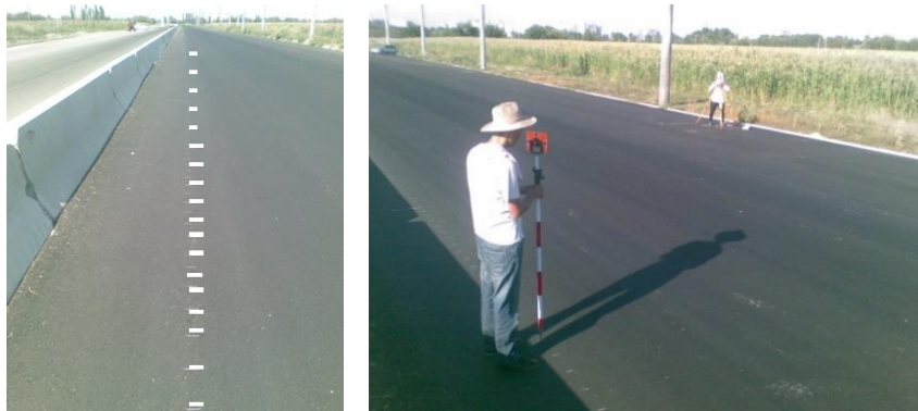
1.18-rasm. Qoplama yuzasini belgilash va o'lchash ishlari
