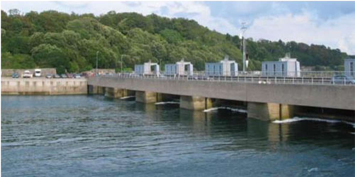
4.8-rasm. Suv sathning ko'tarilib tushish prinsipi asosida ishlaydigan katta gidroelektrstansiya.
