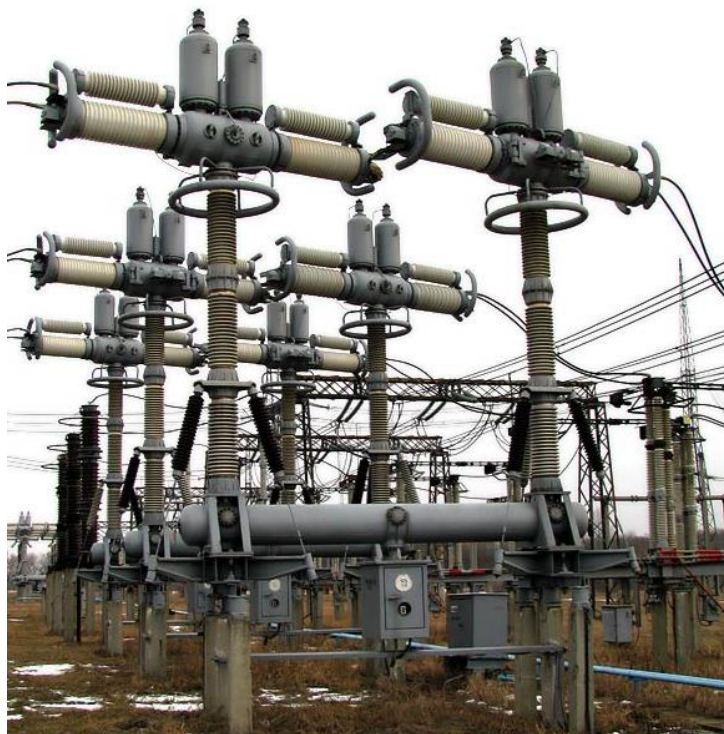
14.6- rasm. Havoli uzgichlarning tashqi ko‘rinishi
