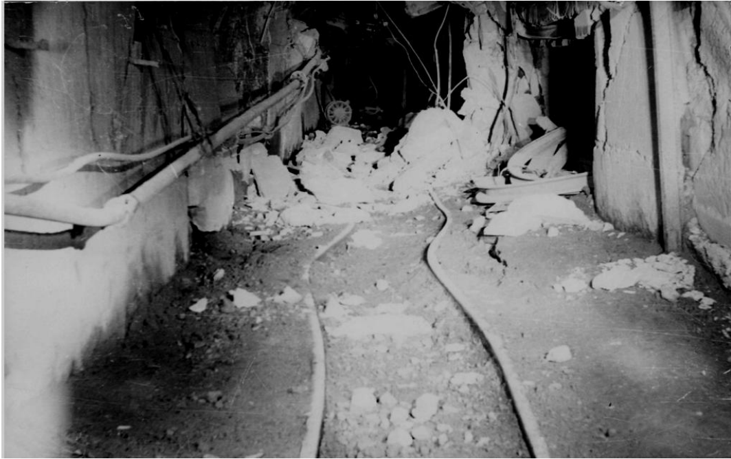
Рис. 5.2.12. Искривление путей в западной части орта 19
