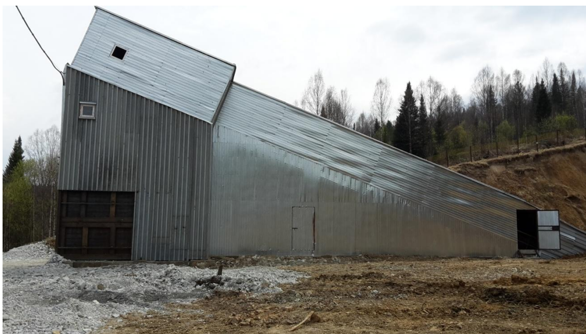
Рис. 2.4.10. Копер наклонного конвейерного ствола
