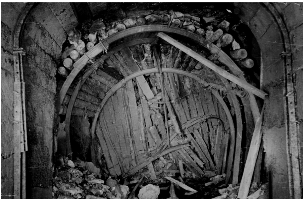
Рис. 5.2.7. Обрушение временной крепи в орте 16, горизонт –210 м
