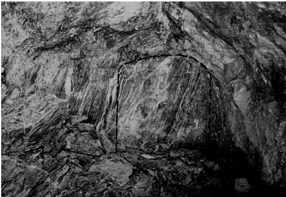
Рис. 5.2.9. Выброс породы в орте подсечки блока 18
