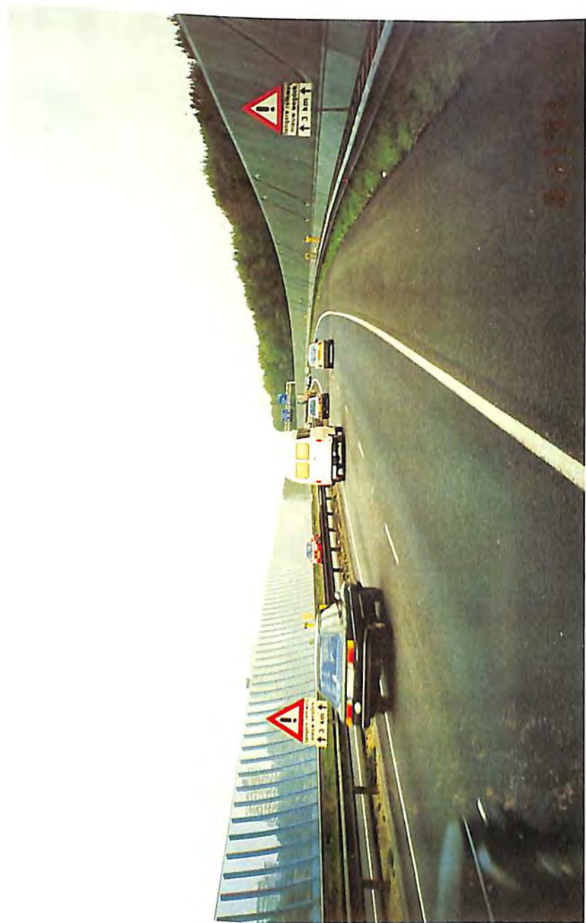
Рис. 2—5. Конструкции и варианты размещения шумозащитных экранов вдоль автомагистралей (данные НИИ Строительной физики)
