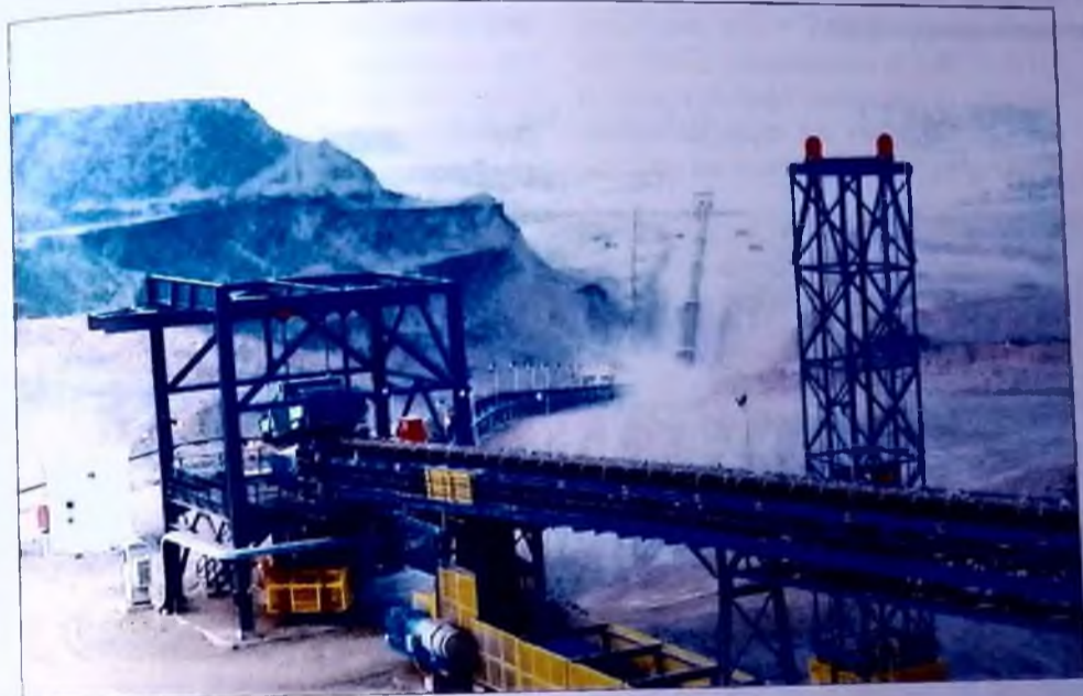
Транспортирование руды от забоя до промежуточного рудного накопителя
