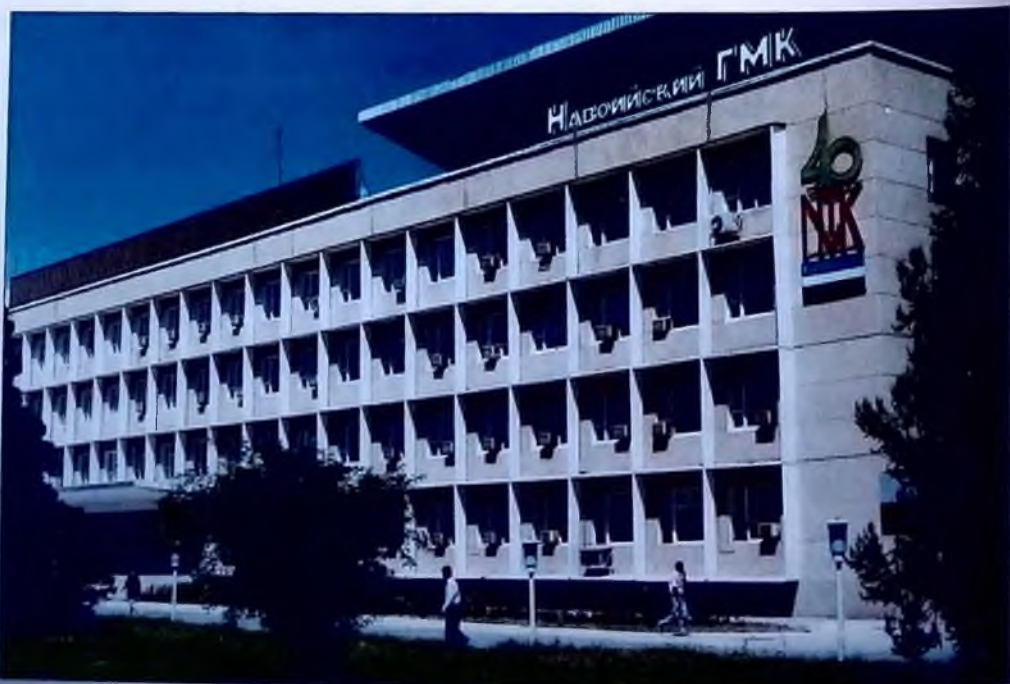
Здание управления Навоийского ГМК
