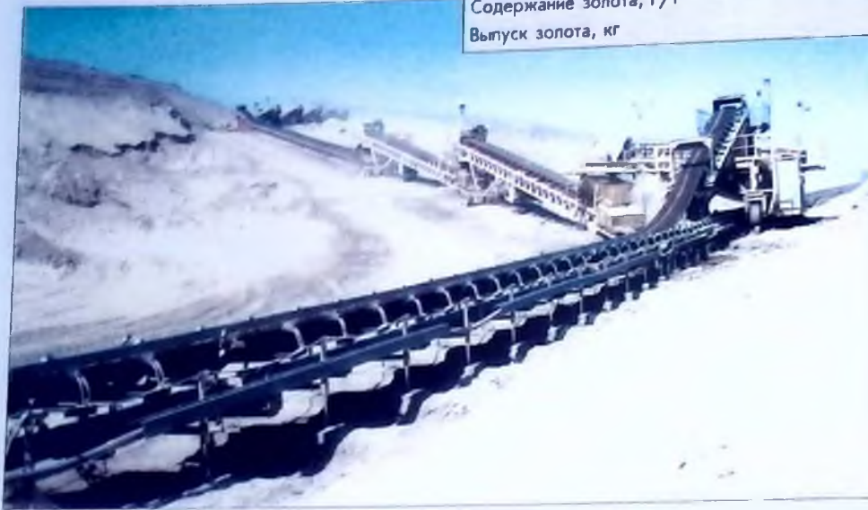
Система подачи руды в штабель с помощью конвейерных перегружателей
