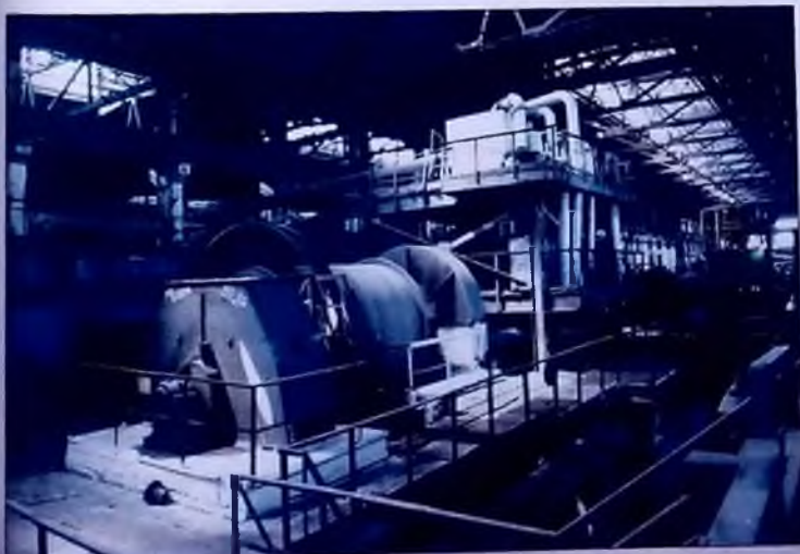
Главный корпус медной обогатительной фабрики
