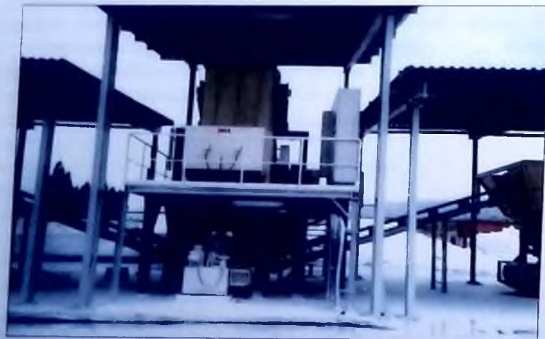
Установка дробления исходного сырья на дробильно-сортировочной фабрике
