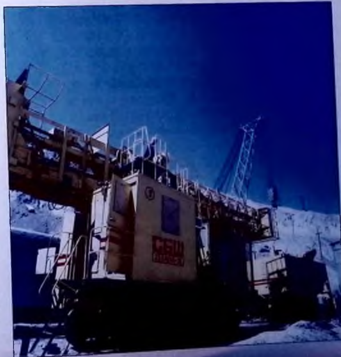
Монтаж новых буровых станков
