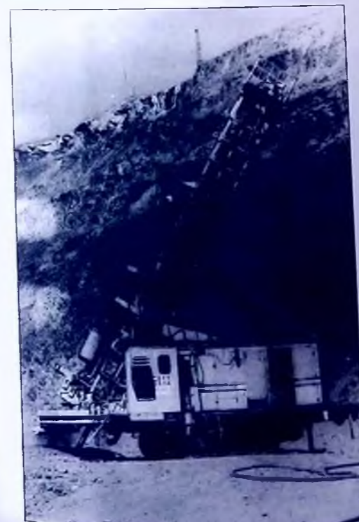
Рис. 2. Станок СБШ-190/250-60 для бурения скважин щелевого экранирования
