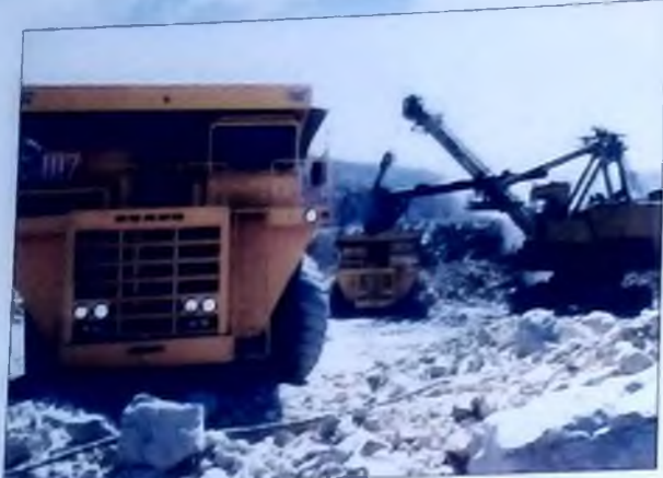
Выемочно-погрузочные работы в карьере «Кальмакыр»
