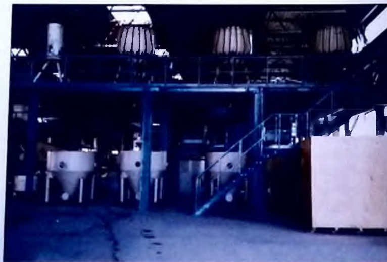
Цех циклонного обогащения
