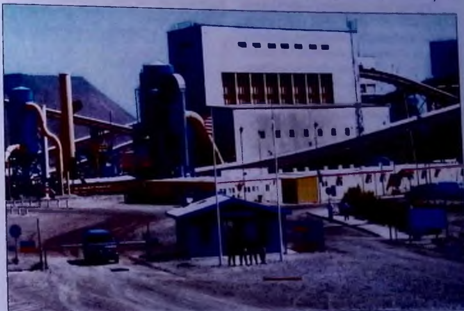
Корпус IV стадии дробления и система аспирации
