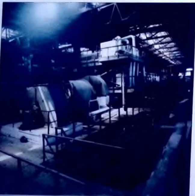
Главный корпус медной обогатительной фабрики
