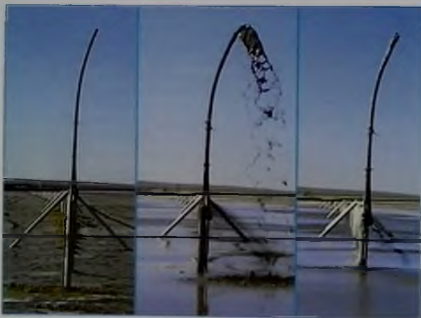
Рис. 3. Намыв с низких эстакад. Результат суточного намыва
