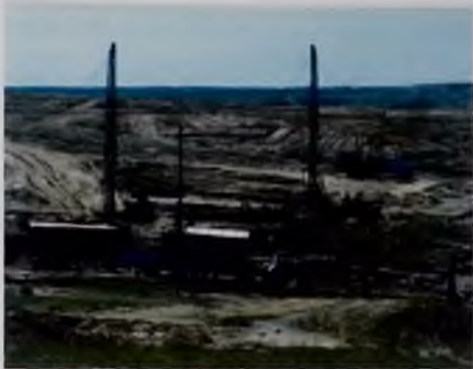
Участок буровых работ в Южном рудоуправлении
