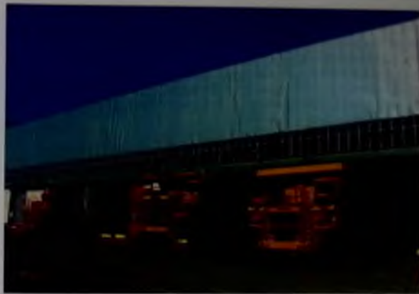
Новый производственный бокс УАТ
