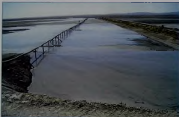
Рис. 2. Летний намыв на отметку 311,0 м
