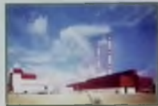
Обогатительная фабрика, ОАО «Карельский окатыш»
