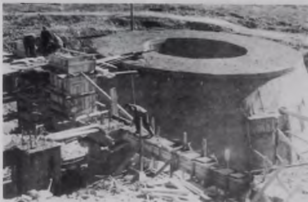
Закладка фундамента Большого металлургического завода
