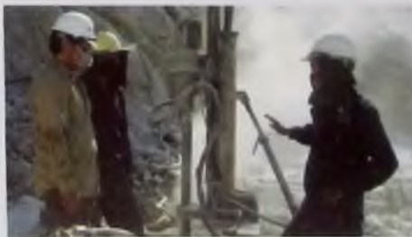
Буровые работы с помощью пневмоударного инструмента ЗАО «МХ» на карьере г. Дананга, Вьетнам
