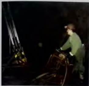
Буровой станок BP-100 производства ЗАО «МХ» в условиях ПР Гайского ГОКа
