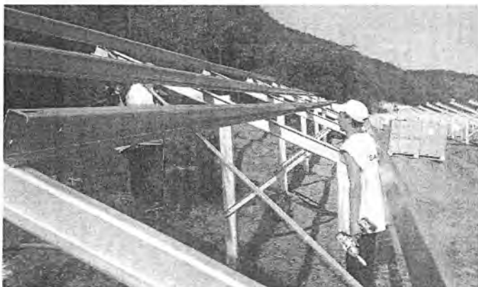
4.28-rasm. Quyosh fotoelektrik stansiyasining karkas qismini o'rnatish
