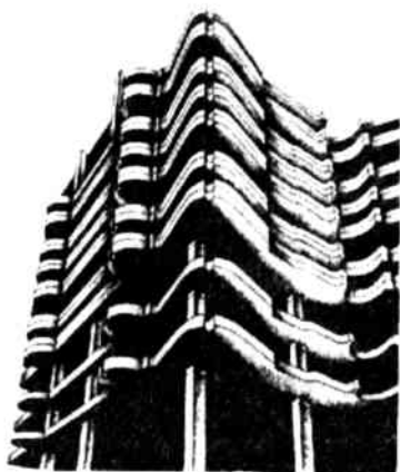
13.6-rasm. Qavatlarni ko'tarish metodi bilan quriladigan bino ko'rinishi
