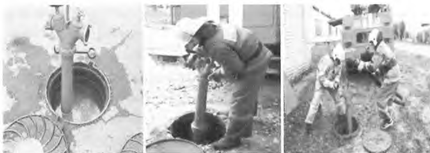
47-rasm. Yer osti gidranlarni oʻrnatilish jarayoni.
