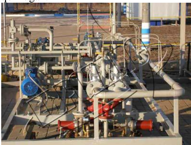
2.4 - rasm. «YeVROGALS» suyuq gaz tarqatish texnologik tizimlari:
