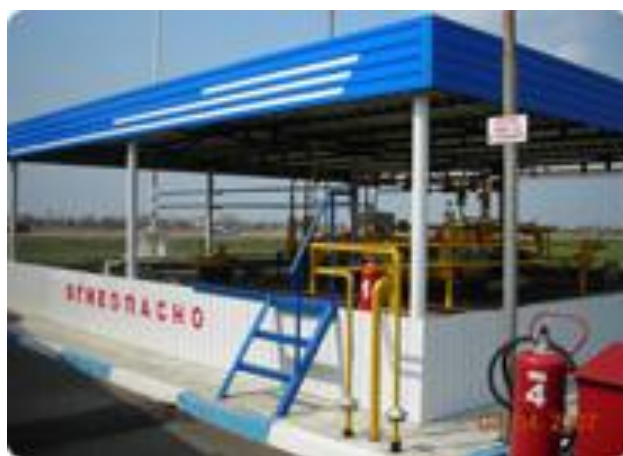
2.3-rasm. "GTC" rusumli suyultirilgan gaz quyish shoxobchasi.
