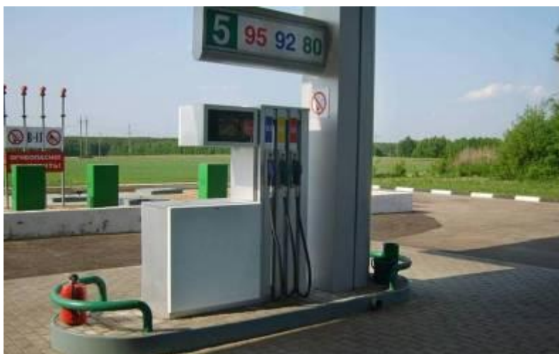
1.3-rasm. YOQSHdagi orolcha va unga o'rnatilgan yonilg'i tarqatish kalonkasi.
