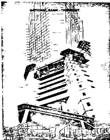
37 расм. Монолит бетондан сирғалувчи опалубкалар ёрдамида бунёд этилган Ўзбекистон Миллий Банкнинг биноси.
